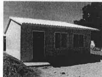
CONSTRUCCION DE 100 AULAS NORESTE DEL ESTADO DE GTO. 2003-2007
