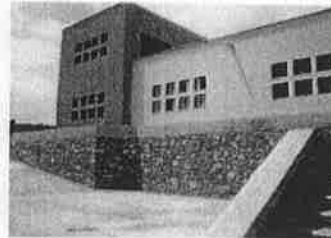
CONSTRUCCION DE CENTRO DE SALUD C-8 TIERRA BLANCA, GTO. 2003-2004
