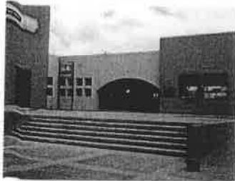
CONSTRUCCION DE CENTRO DE SALUD C-8 SANTA CATARINA, GTO. 2003-2004
